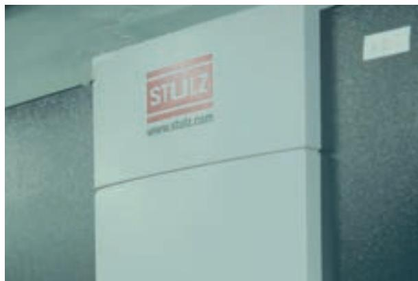
Климат в машинном зале поддерживается за счет 19 прецизионных кондиционеров STULZ с резервированием по схеме N+2, обеспечивающих поддержание температуры в «холодных коридорах»  $+20\pm2^{\circ}\text{C}$ . Климатические установки обеспечивают также поддержание требуемой относительной влажности воздуха в пределах  $52 \pm 7\%$ . Холодный воздух поступает к оборудованию через систему перфорированных фальшполов.
